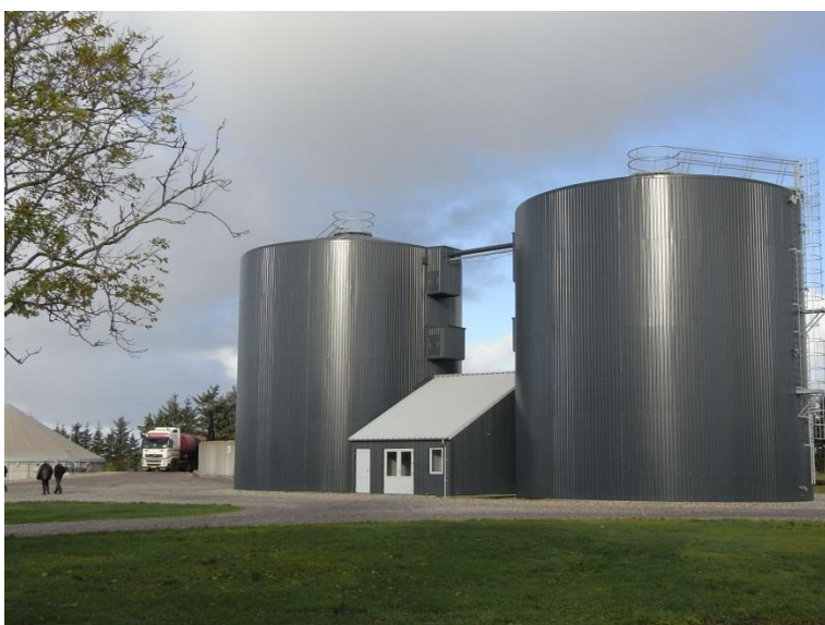
Billede 1: Reaktor- og gaslagertanke 1
