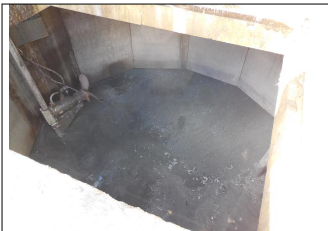
Billede 3: Underjordisk tank med Landia pumpe/snitter 3
